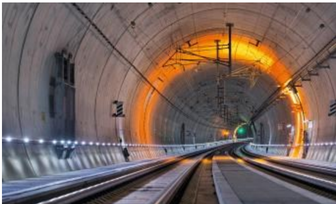
Un tratto della galleria di servizio (a canna unica) del tunnel di base del Brennero, tra Fortezza e Innsbruck, che sarà pronto tra sei anni e agevolerà grandemente i collegamenti dall'Italia all'Austria e alla Germania.
